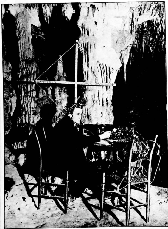
BENJAMIN KING, ingeniero del departamento de Radio de Washington acaba de realizar interesantísimos experimentos con los aparatos receptores. Aquí lo vemos, en el fondo de una caverna en Newmarket, recibiendo comunicaciones con una antena colocada a media milla de distancia de su entrada, a ciento ochenta pies bajo tierra.
